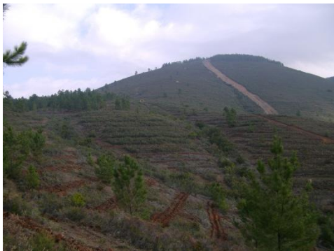
Preparação do terreno - Fevereiro 2011 - Penamacor
