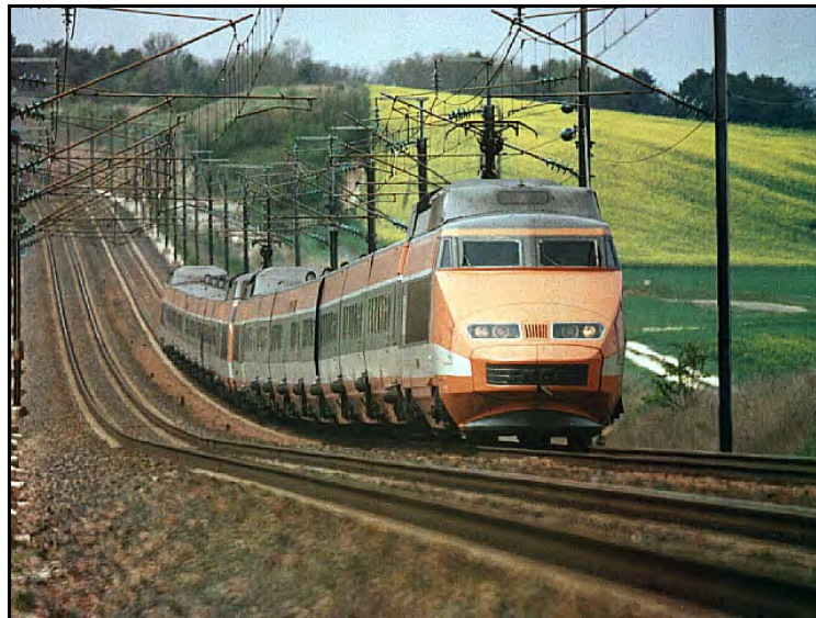
Línea de alta velocidad TGV Atlantique.
