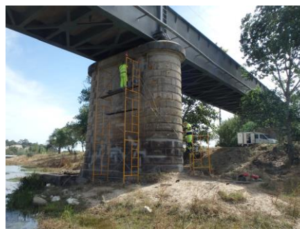
Refechamento Juntas e Fissuras
