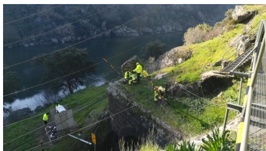
Trabalhos de Sinalização
