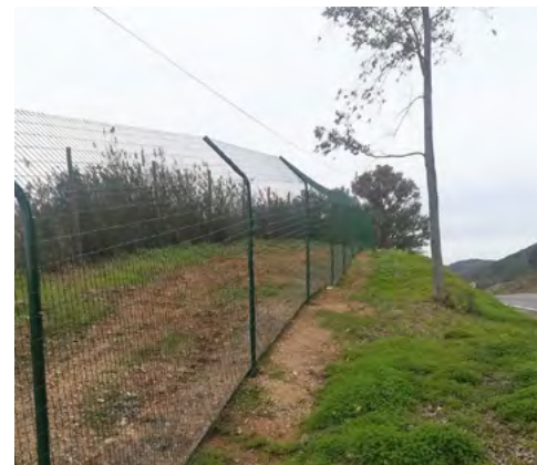
Vedação específica para proteção do lince-ibérico
