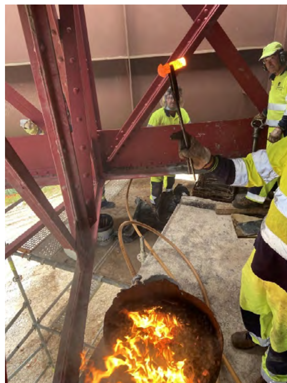
Trabalhos Brigada de Pontes
