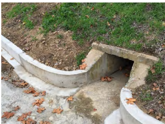
Barreiras de encaminhamento de anfíbios para Passagens Hidráulicas
