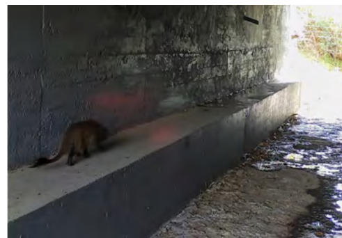
Carnívoros selvagens a utilizar os passadiços de fauna em Passagens Hidráulicas e Obras de Arte (fonte: Universidade de Évora)
